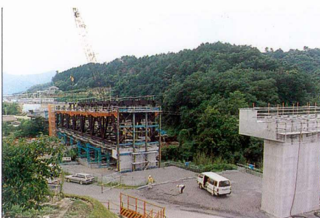
菖蒲谷川橋梁の架橋工事(平成5年8月)
