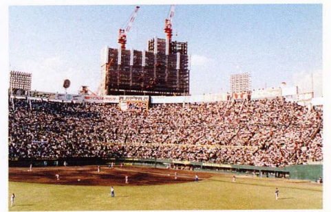
満員のスタンド後方に建設中の南海サウスタワーホテル大阪
