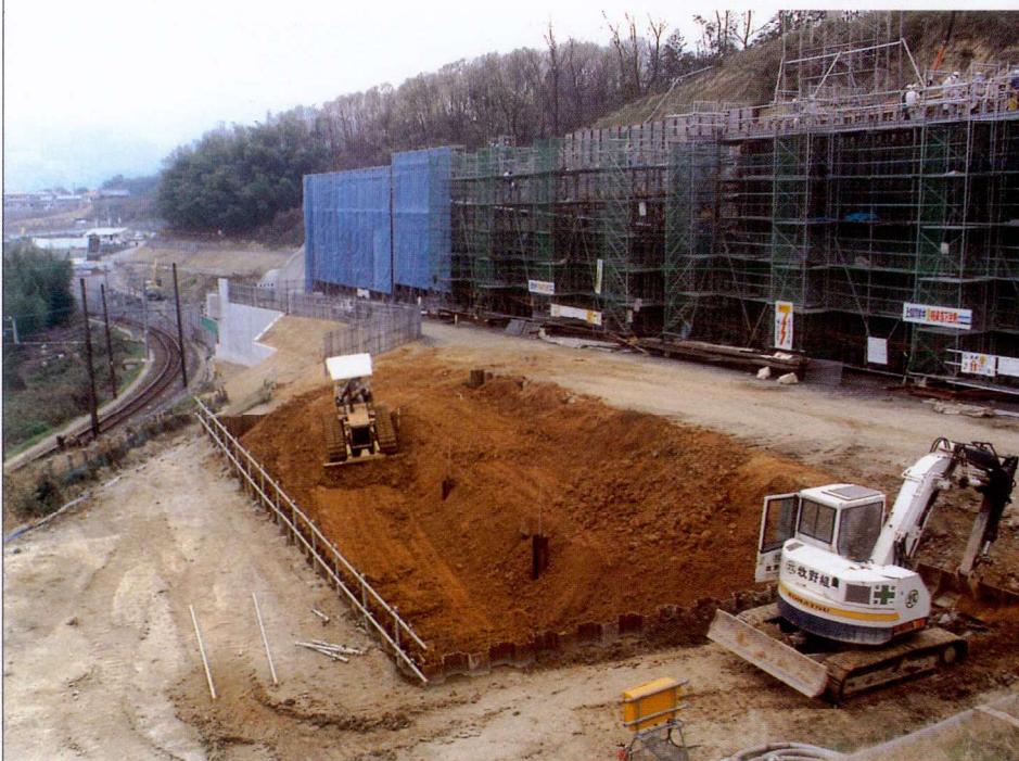
擁壁工事中の小原田車庫(平成4年4月)
