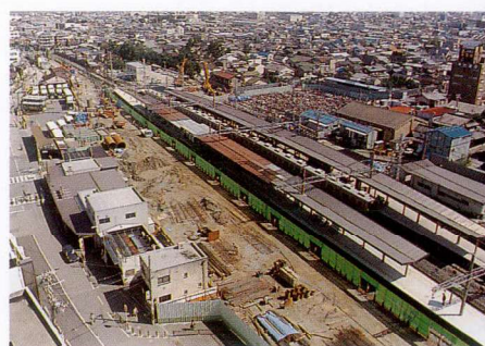
旧駅舎が撤去され高架化工事が進む岸和田駅付近(平成3年2月)
