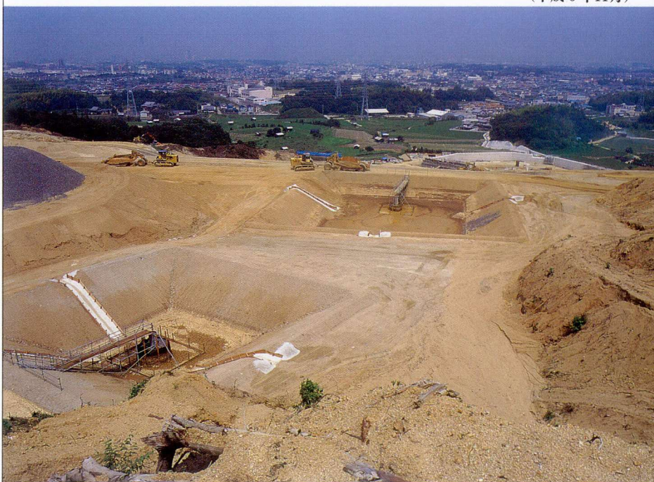
造成中の熊取南部地区(平成7年7月)
