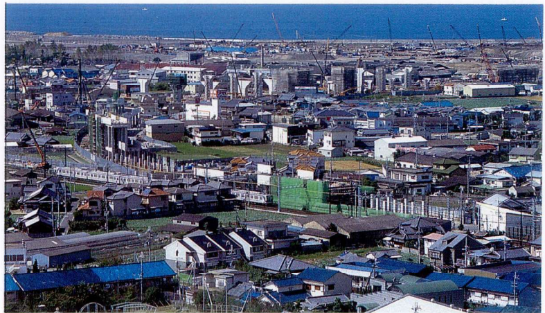
南海分岐線の建設工事(平成4年10月)
