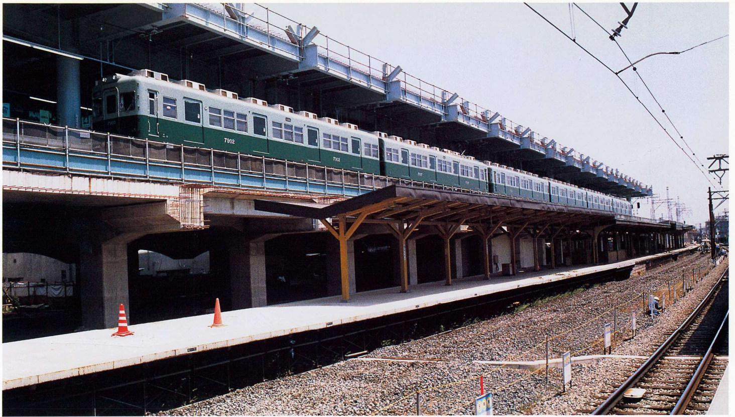
上り線が高架で営業開始した岸和田駅(平成4年5月)
