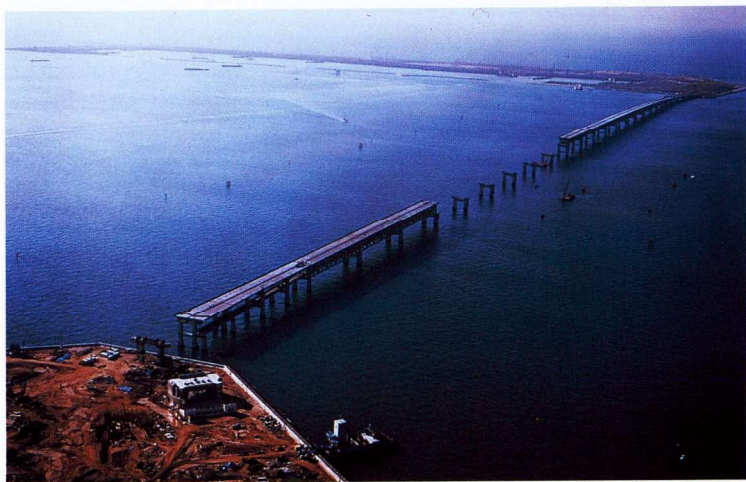
建設途上の空港連絡橋（平成3年2月）
