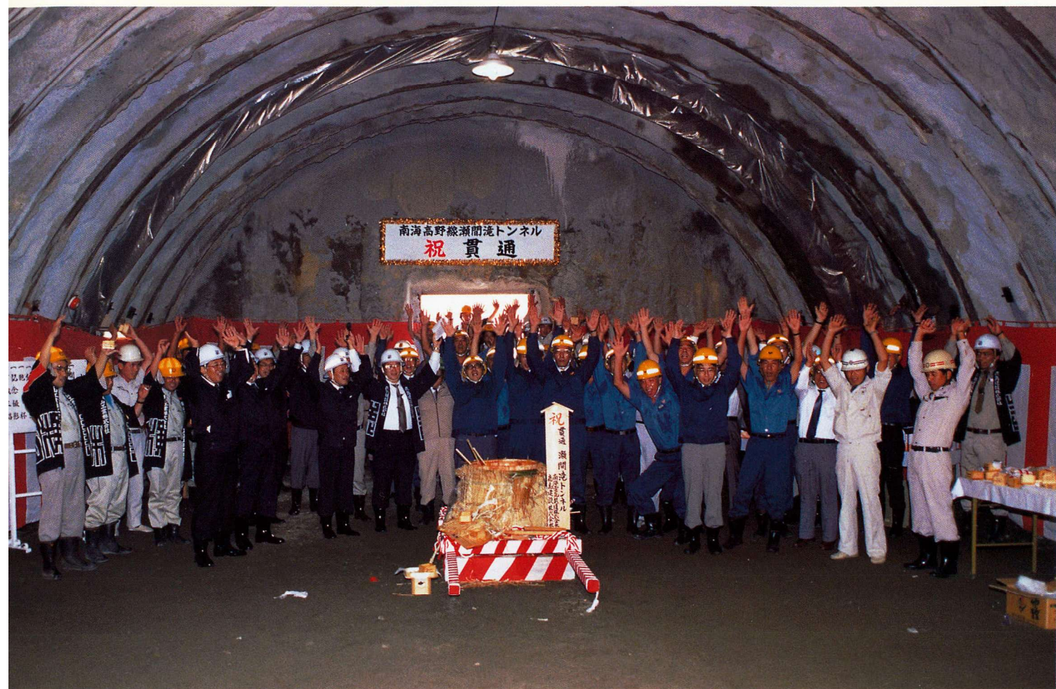
高野線複線化工事のトンネル掘削では最終の瀬間滝トンネルが貫通(平成3年9月)
