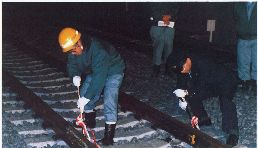
泉佐野市連立工事(第1期)竣工のレール締結式(平成7年3月)
