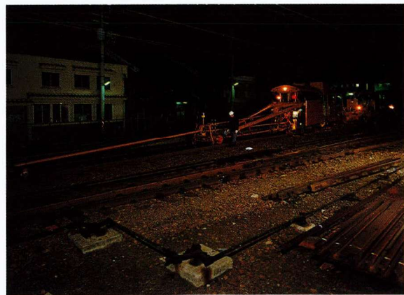
大型機械「マルタイ」による保線作業
