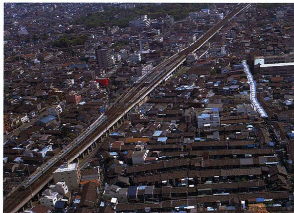
大阪市内連続立体化工事(南海本線・粉浜駅付近)
