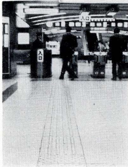
身体障害者設備 鉄道は、全てのお客さまに安心して乗っていただくための努力を欠かすことができない。身体障害者設備もその一つ。写真は駅コンコースに設置した「誘導タイル」
