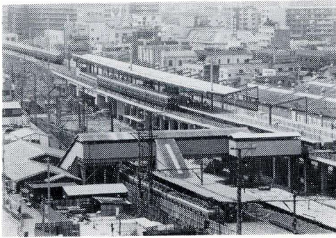
堺市内連続立体化工事 上り線高架橋が完成した南海本線堺駅 〔五十八年七月〕。六十年五月完成後は、 二〇か所の踏切が廃止され、駅前整備事 業が本格化する。
