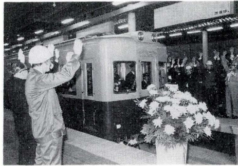
難波駅第一期工事が完成
