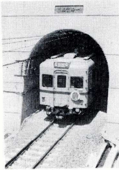
一路貫光 高野線複線化工事のうち最大の難工事と見られていた「新紀見トンネル（一八五三m）」は四十七年六月着工し、四年後の五十一年四月四日に開通した。坑口には川勝社長の揮毫になる「一路貫光」の扁がくが掲げられている。
