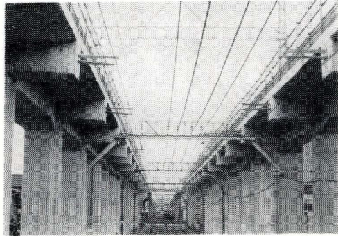
連続立体化工事
