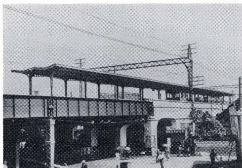
高架上に完成した今宮戎停留場
