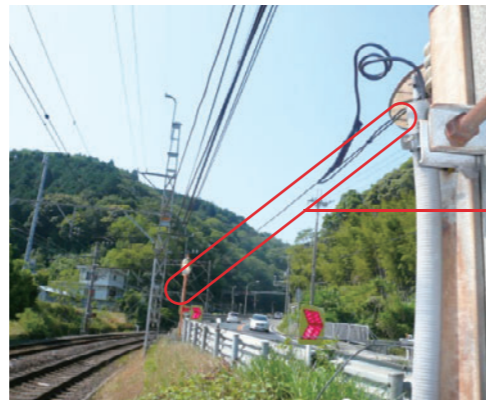
自動車転落警報装置の検知線
