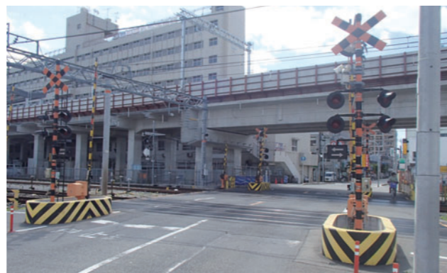
南海本線(高石市内)連続立体交差事業の工事進捗状況
