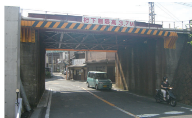
桁下有効高表示と防護柵
