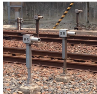
踏切障害物検知装置
