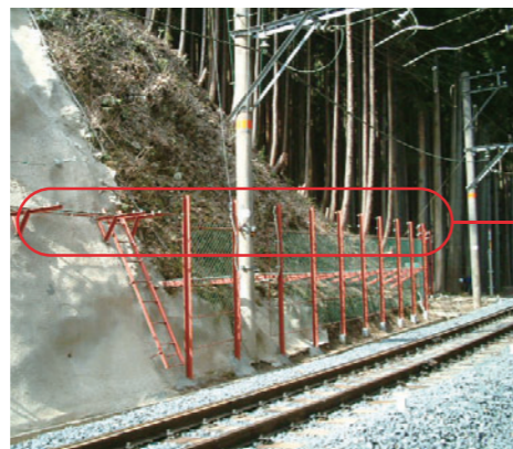
落石警報装置の検知線
