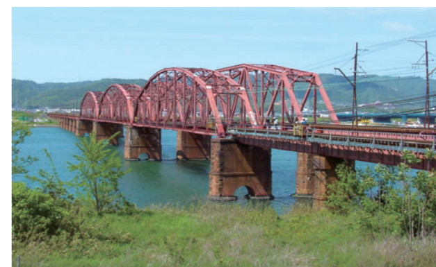
南海本線・紀ノ川橋梁(紀ノ川～和歌山市間)
