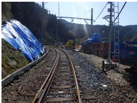
上古沢駅の線路全景(難波駅側から撮影)
