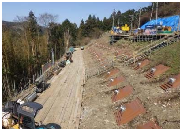
アンカー工全景
