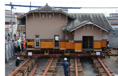
堺市内連続立体交差事業(諏訪ノ森駅旧駅舎)
