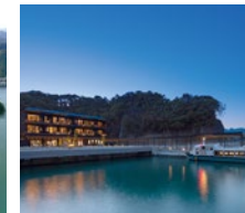
2019年オープンの客室棟「凧の抄」
