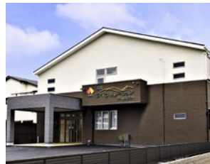
南海ライフリレーション岸和田吉井
