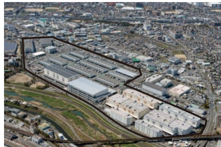
北大阪流通センター (総敷地面積 約272,000㎡)
