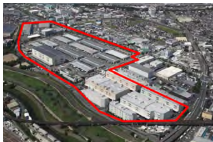
北大阪流通センター（総敷地面積 約272,000㎡）
