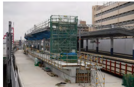
高石市内連続立体交差事業(高石駅部)
