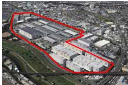
北大阪流通センター (総敷地面積 約272,000㎡)
