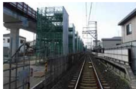
高石市内連続立体交差事業(羽衣駅～高石駅間)
