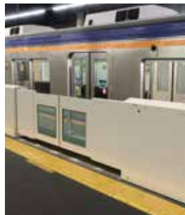
難波駅の一部に可動式ホーム柵を設置します(イメージ)
