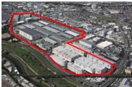
北大阪流通センター（総敷地面積 約272,000㎡）
