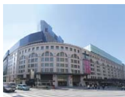
南海ビル外壁美装化
