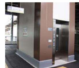
和歌山市駅に新設したエレベーター
