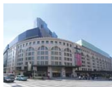
南海ビル外壁美装化
