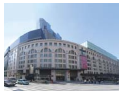
南海ビル外壁美装化
