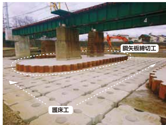
洗掘防止対策工事（男里川橋梁）
