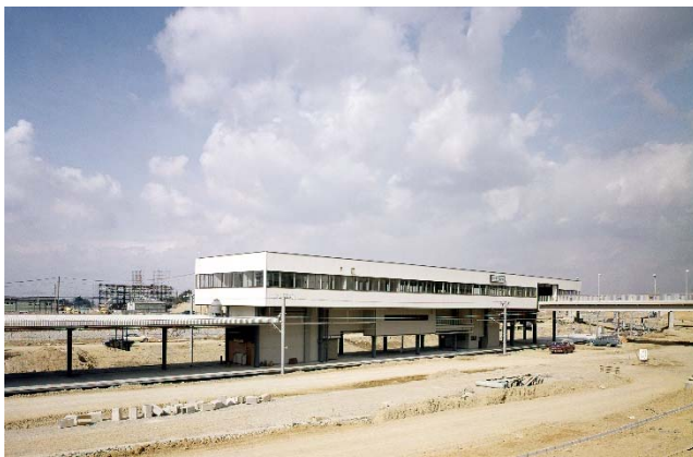
左：竣工間近の泉ヶ丘駅（1970年12月頃撮影）
