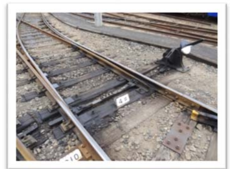
※ 電車の方向を変える転てつ器
