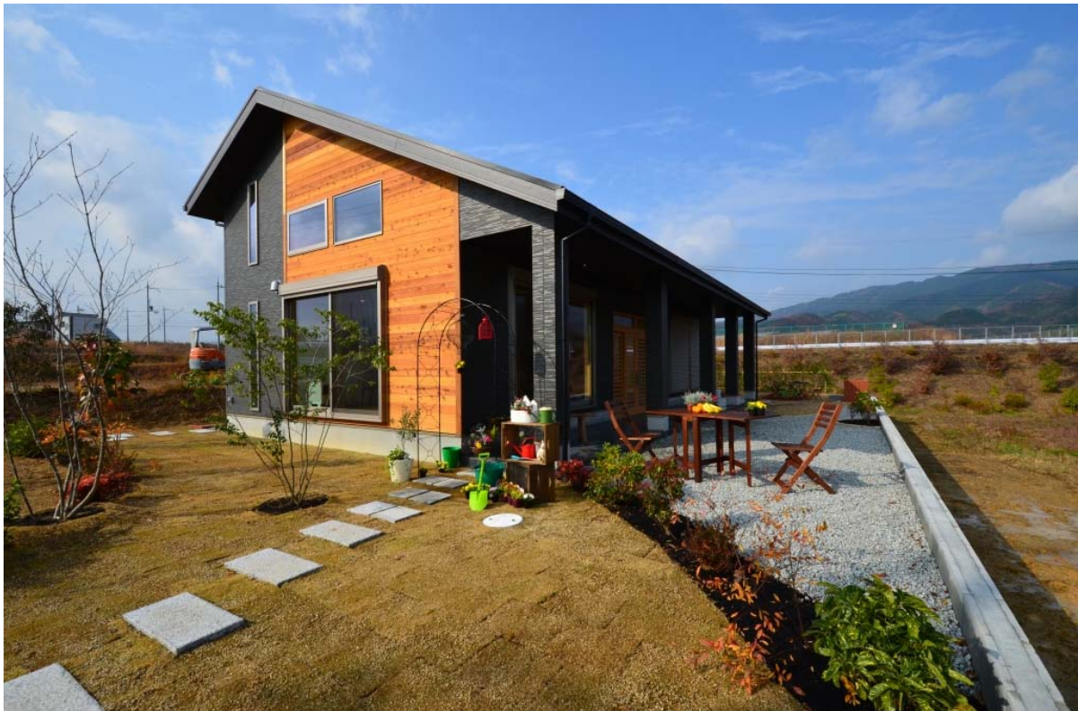
広さが魅力の敷地面積500㎡超（写真はモデルハウスの建つ5号地）
