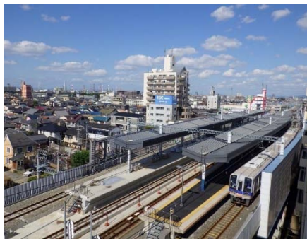
上り線が高架化する高石駅付近（10月1日撮影）
