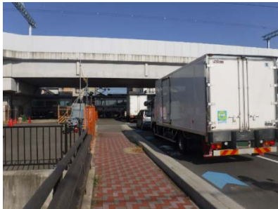
都市計画道路新村北線（高師浜線共用踏切）
