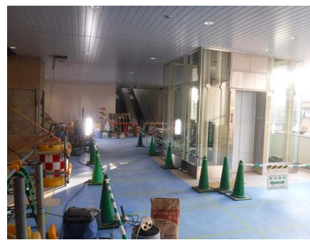
工事が進む羽衣駅コンコース階（11月10日撮影）
