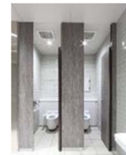
換気口の設置（春木駅西口）
