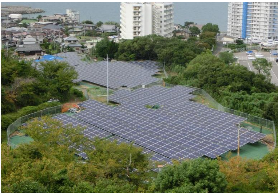
南海淡輪発電所の太陽光発電設備
