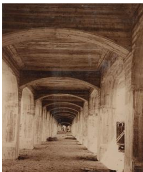
<高架竣工当時>
