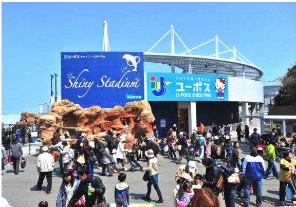
シャイニースタジアムの外観
