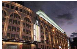
南海ビル改修
