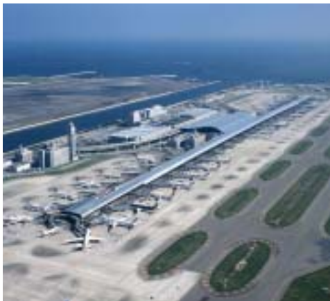
完全24時間空港となった関西国際空港
