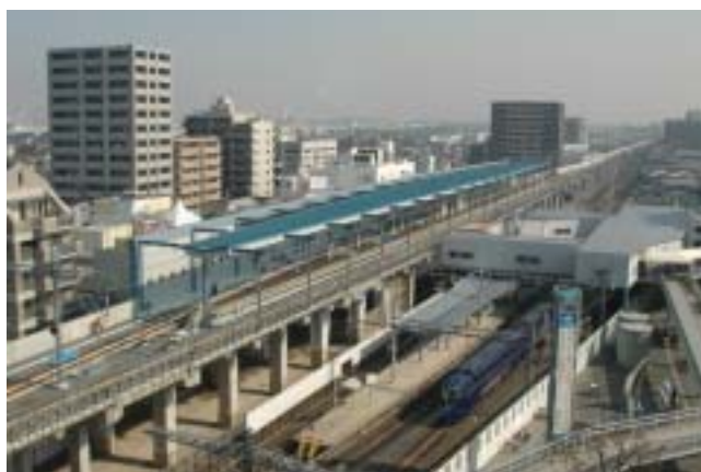
高架化工事が進む泉大津駅（平成20年3月11日撮影）
