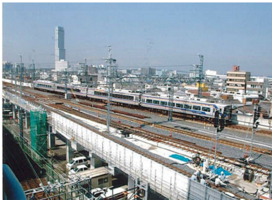
泉佐野市内連続立体交差事業の工事の様子
