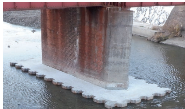
津田川橋梁洗掘防止対策工事
