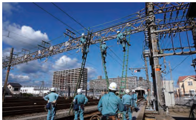
電力係員による復旧訓練
