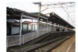
【吉見ノ里駅】スロープの整備 スロープの距離を長くすることで、こう配を緩和
