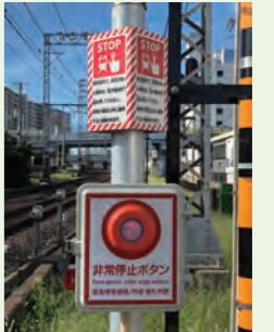
踏切の非常停止ボタン
