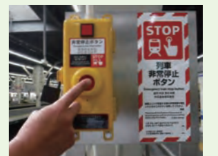
駅ホームの非常停止ボタン
