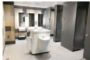
【岸和田駅】女性トイレ
