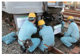
検車係員による復旧作業
