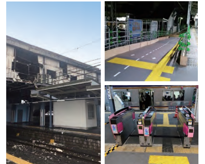
左: 火災発生後の尾崎駅駅舎の様子 右: 仮復旧した尾崎駅の様子(上: 4番線上に設置した仮設通路(スロープ)、下: ホームに設置した自動改札機)
