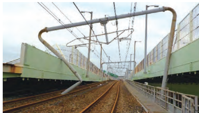
下り線道路橋の横滑り(約4m)により被災した鉄道
