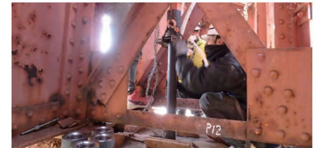
南海本線 紀ノ川橋梁の橋脚補強(鋼棒の挿入)
