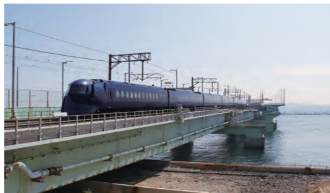
運転再開後の空港連絡橋
