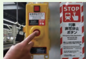
駅ホームの非常停止ボタン
