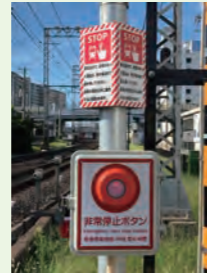
踏切の非常停止ボタン
