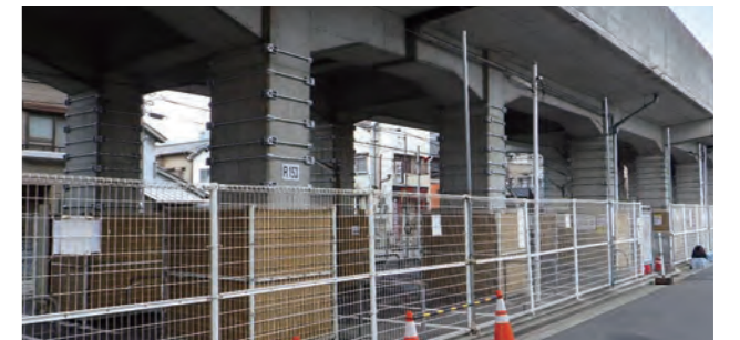
高架橋柱の耐震補強(柱に鋼材を巻き補強)
