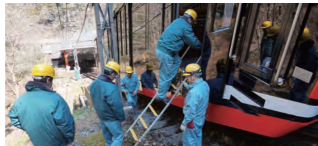
駅間停車したケーブルカーからお客様役の係員を避難誘導
