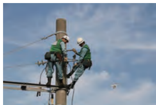
電力係員による復旧作業
