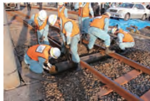
保線係員による復旧作業
