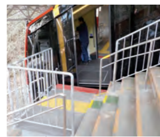
【高野山駅】鋼索線(高野山ケーブルカー)の乗降口をフラット化
