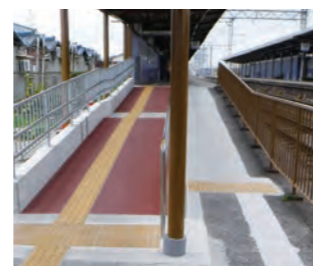
【井原里駅】ホーム・改札口間のスロープ改修
