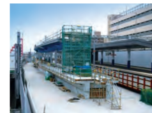
高石市内連続立体交差事業(高石駅)
