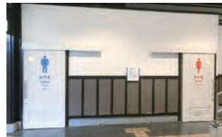
【極楽橋駅】トイレ外観
