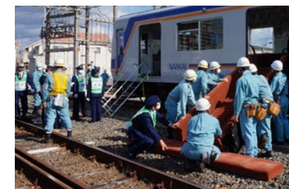
事故復旧総合訓練
