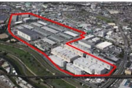
北大阪流通センター（総敷地面積 約272,000㎡）
