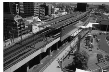
泉大津市内連続立体交差事業(泉大津駅)
