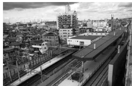
高石市内連続立体交差事業(高石駅)
