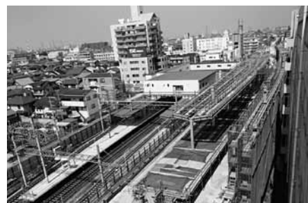
高石市内連続立体交差事業(高石駅)
