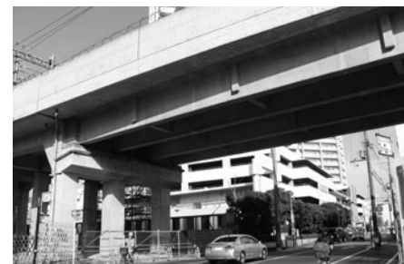
泉大津市内連続立体交差事業(踏切が除去された道路)
