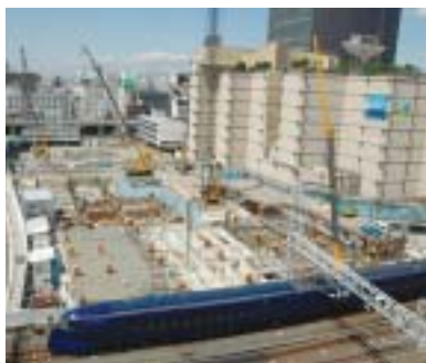
なんばパークス南側で進む工事の様子 (手前:なんばパークス第2期、奥:ザ・なんばタワー)
