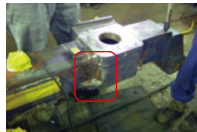
台車のき裂発生場所
