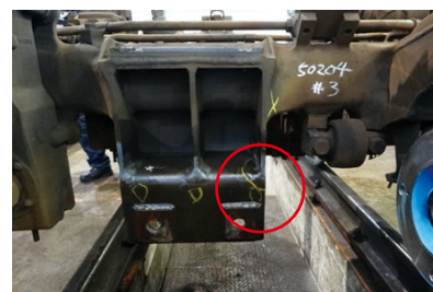
台車のき裂発生場所
