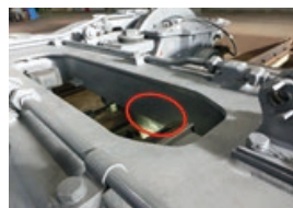
台車の亀裂発生場所
