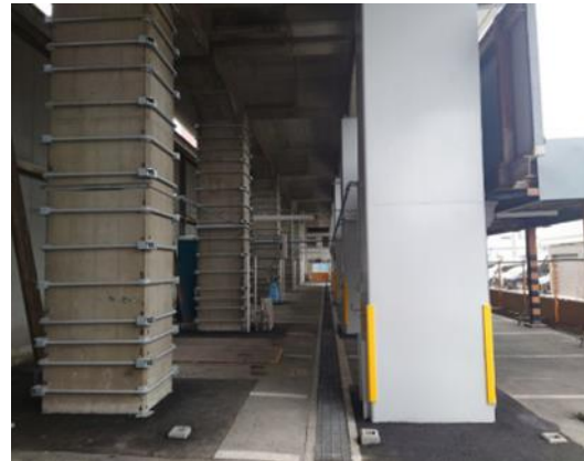
湊駅～石津川駅間高架橋耐震補強工事
