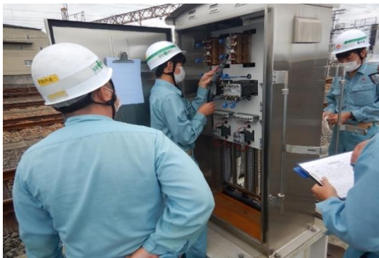
商用軌道回路装置復旧訓練 (施設部・電気 信号担当)
