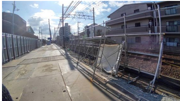
連立工事事務所足場倒壊復旧訓練
