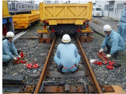
軌道作業車実技教育(施設部・工務)
