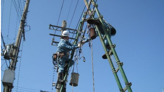
技能競技会(施設部・電気 電路担当)
