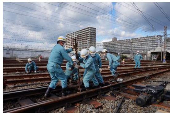
保線係員による復旧訓練
