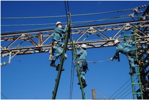
電力係員による復旧訓練
