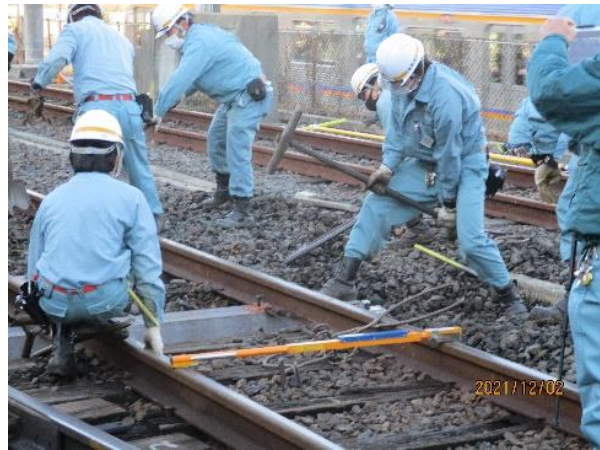
保線係員による復旧訓練
