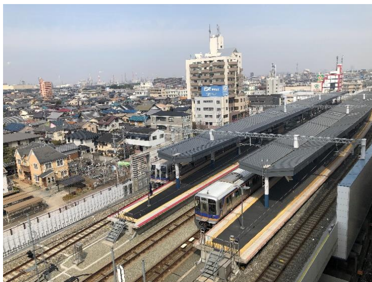
高石市内連続立体交差事業(高石駅完成)
