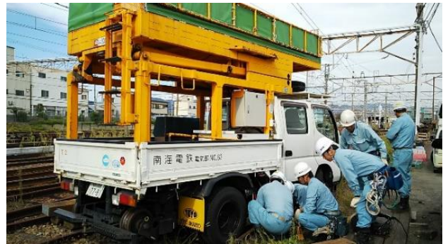
軌道作業用自動車の脱線復旧訓練 (施設部・電力担当)
