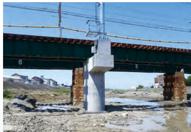
12か所すべての橋脚に計測器を設置
