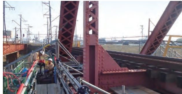
南海本線 紀ノ川橋梁の橋脚補強 (鋼棒の挿入)
