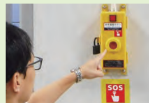
駅ホームの非常通報ボタン
