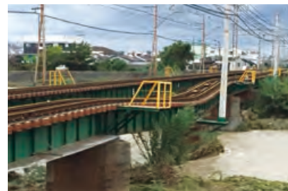
橋脚が傾きレールがゆがんだ下り線
