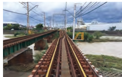
橋脚が傾きレールがゆがんだ下り線
