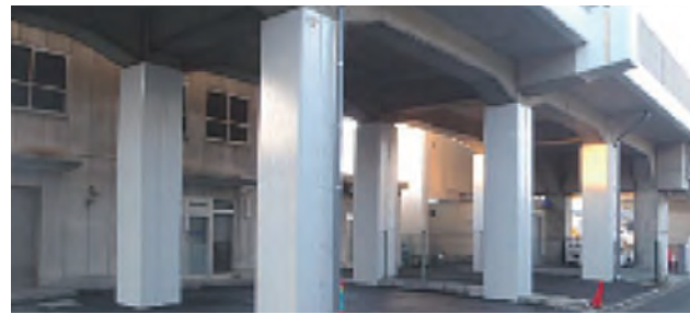
高架橋柱の耐震補強 (柱に鋼板を巻き補強)
