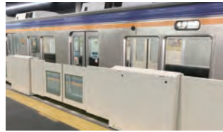
可動式ホーム柵設置イメージ
