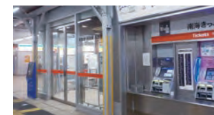
駅施設を2階から1階に移設し、オープンカウンターの窓口を設置（和歌山市駅）
