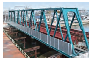
堺市内連続立体交差事業 (石津川仮橋梁)
