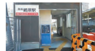
スロープを設置し、東口を新たに増設（鶴原駅）
