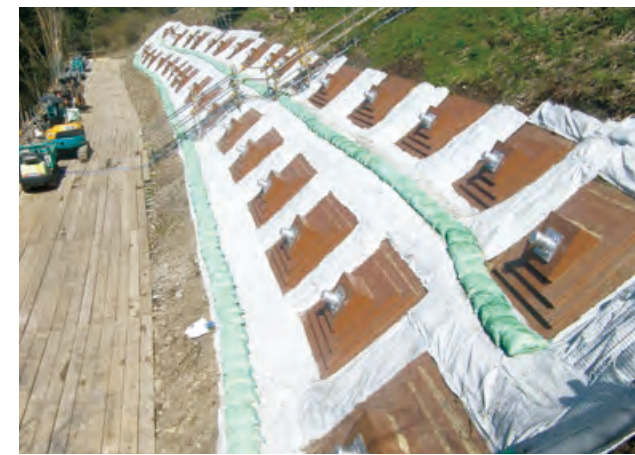
のり面に2列のアンカー工を施工
