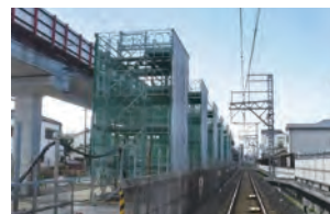
高石市内連続立体交差事業 (羽衣駅～高石駅間)
