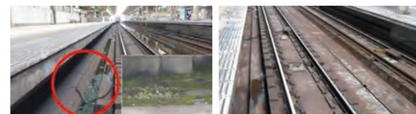
高圧洗浄機による線路上の苔の除去(天下茶屋駅)(左:洗浄前、右:洗浄後)
