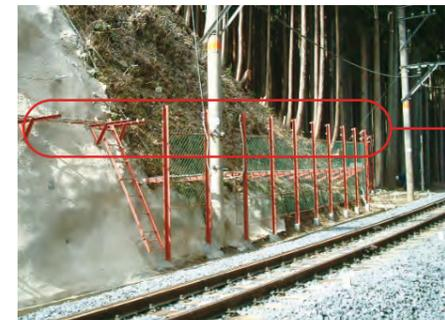
落石警報装置の検知線
