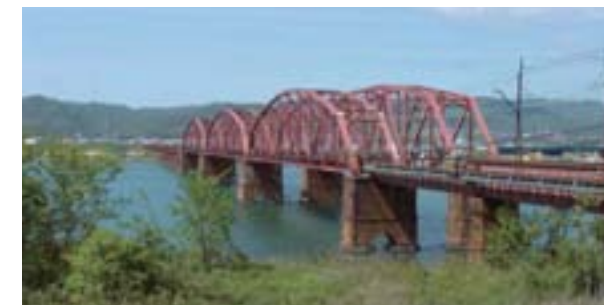
南海本線 紀ノ川橋梁
