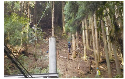
樹木伐採状況
