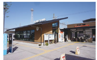
吉見ノ里駅舎とコミュニティ施設
