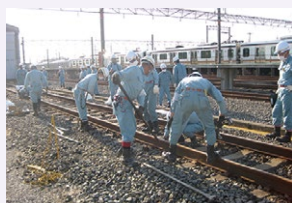
線路設備の復旧作業
