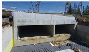
道路と線路との立体交差工事
