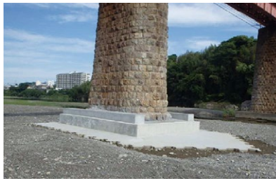
高野線紀ノ川橋梁P3橋脚洗掘防止対策工事
