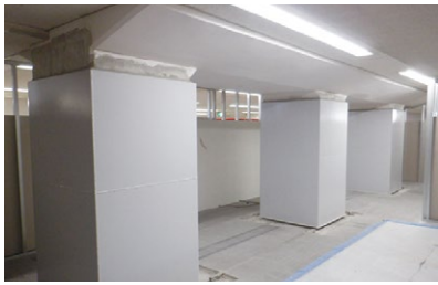
岸里玉出駅耐震補強
